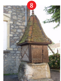
Puits et ancien pavillon de chasse
