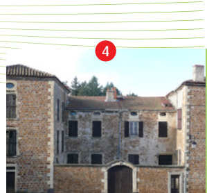
Maison Forte la Ferrière
